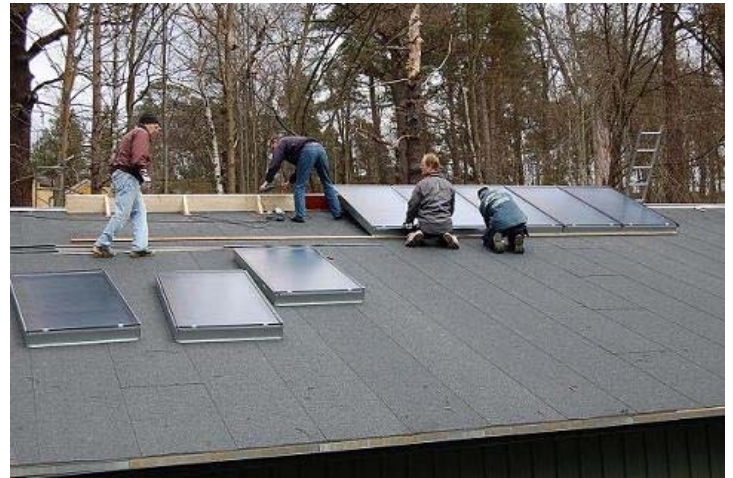
Solfångaren monteras på nya båthallen
